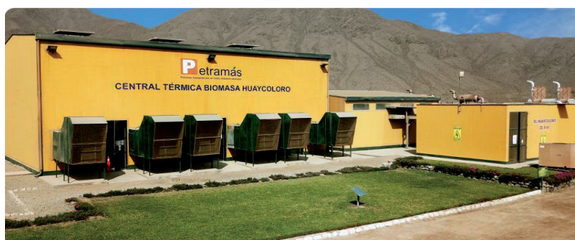
Figura 59. Central Térmica Biomasa Huaycoloro
